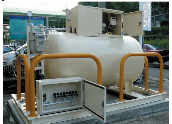
災害対策用バルクと複数のガス栓を備えた設備
